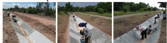
การเคลือบผิวคลองชลประทานด้วยวัสดุเคลือบผิวผสมน้ำยาง
